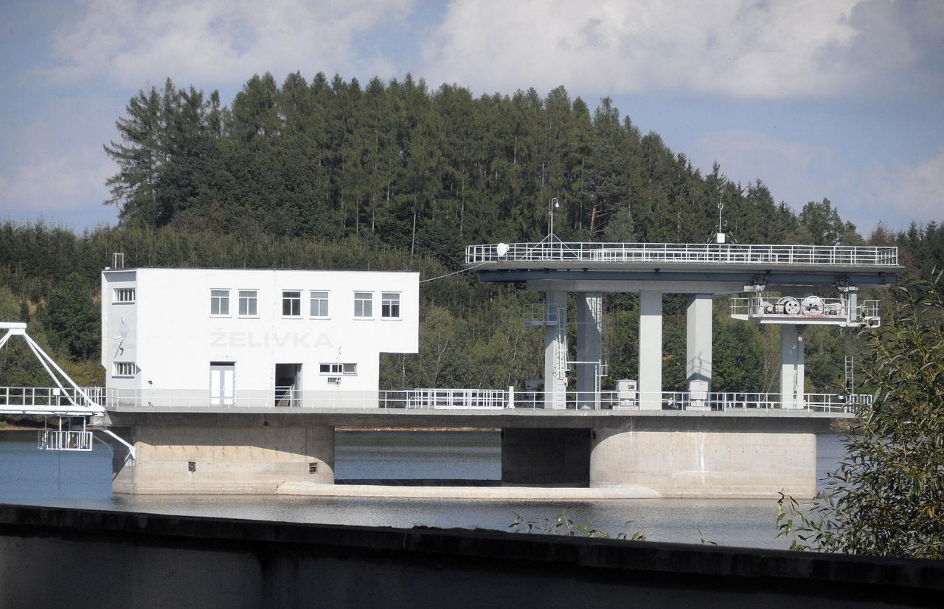
Vodárna Želivka – odběrový profil
